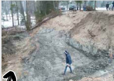
Pregled lokacije ugradnje
