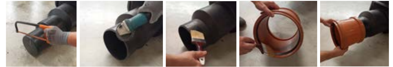
Rezanje reducijskog priključka na željeni promjer
